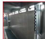
Odsysanie mgły olejowej i emulsji chłodzącej
